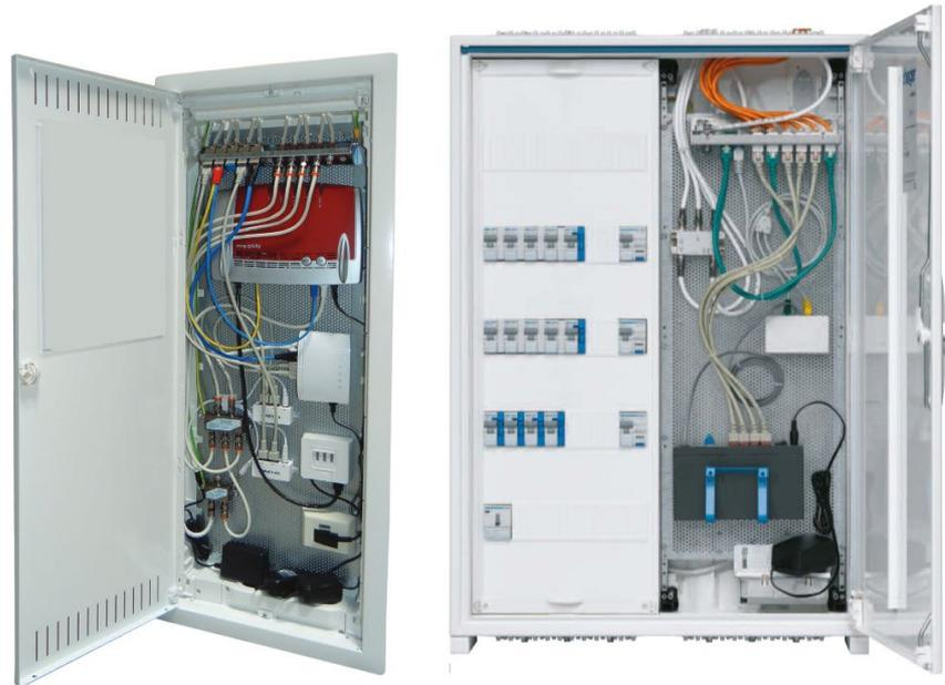
Abbildung 22: Wohnungsverteiler mit und ohne kombiniertem Elektroverteiler
